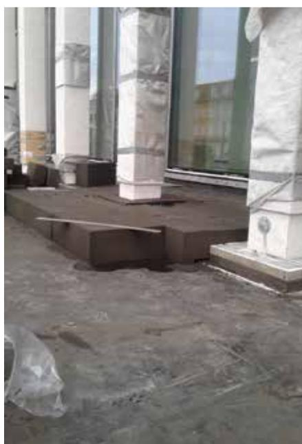
Der Schichtaufbau besteht aus Schaumglasdämmplatten Foamglas T3+ und T4+ mit einer entsprechenden zweilagigen Abdichtung.
