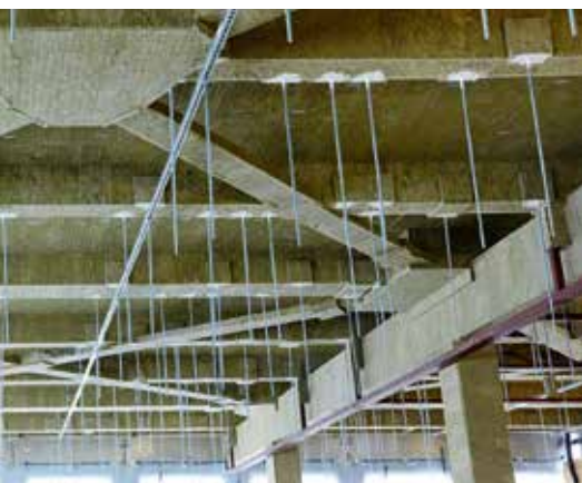
Insgesamt 60.000 m 2 zu isolierender Fläche musste brandschutztechnisch ertüchtigt werden.
