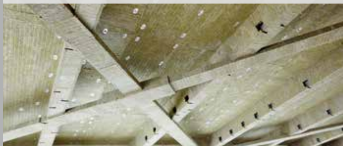
Die Befestigung der Rockwool Brandschutzplatten an den Trapezblechprofilen erfolgte mit Setzbolzen in einem Raster von 450 x 500 mm.
