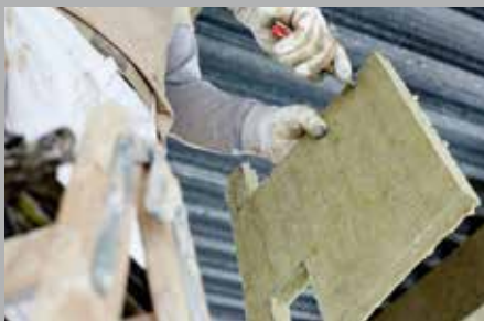
Ein wesentlicher Vorteil der „Conlit Steelprotect Boards“: Sie lassen sich mit einem einfachen Cutter-Messer leicht zuschneiden und exakt anpassen. Bilder: Rockwool
