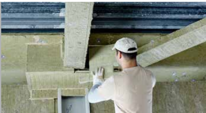
Ein wesentlicher Vorteil der „Conlit Steelprotect Boards“: Sie lassen sich mit einem einfachen Cutter-Messer leicht zuschneiden und exakt anpassen. Bilder: Rockwool
