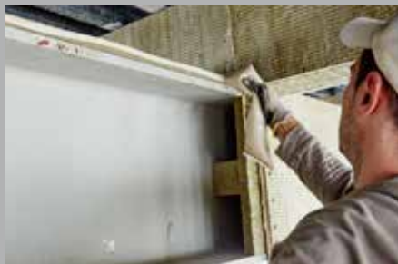
Auftragen des „Conlit Fix“ Systemklebers auf die Stöße der Brandschutzplatten.
