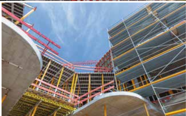
Peri unterstützte den schnellen Baufortschritt der Dreiländergalerie mit Schalung und Gerüst aus einer Hand. Bilder: Peri
