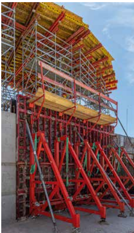
Bestandteil der Peri-Lösung waren Schutzgerüste auf Basis der PERI UP und VARIOKIT Baukastensysteme sowie MAXIMO und Stützbock SB zum einhäutigen Schalen. Bilder: Peri
