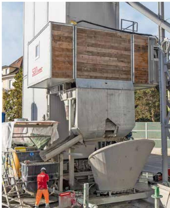
Die Betonabgabe auf der Baustelle erfolgt wahlweise an die angeschlossene Betonpumpe oder über die frontseitige Krankübel-Beschickung. Darüber erkennt man die im Mischermodule integrierte Steuerkabine.
