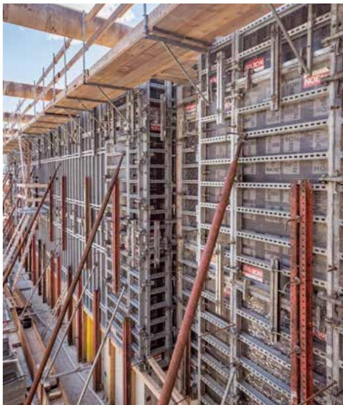
Die selbstsichernde NOEtop-Laufgerüstkonsole kann an jedem Querprofil eingehängt werden und ermöglicht der Mannschaft damit sicheres, flexibles und effizientes Arbeiten. **Bilder: NOE**
