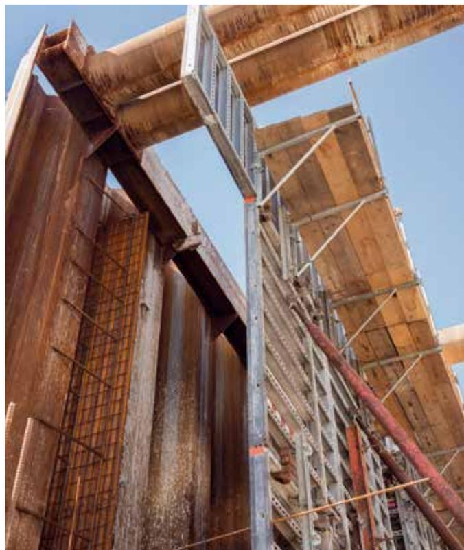
Die NOEtop wurde als einhäufige Schalung eingesetzt. Durch die Verankerung mit der Spundwand konnte auf Abstützböcke verzichtet werden.
