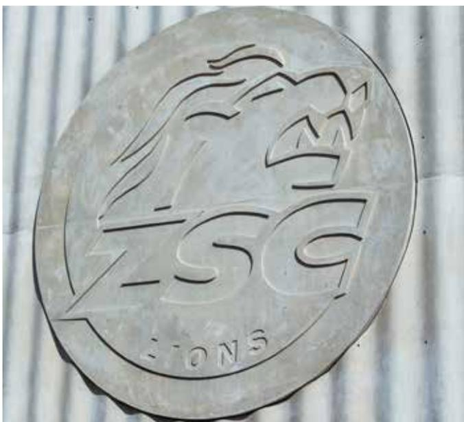
Die vier Logos der ZSC Lions haben einen Durchmesser von über fünf Metern. Die Betonplatte wird auf der Baustelle vorproduziert und anschließend in die Wand versetzt. **Bilder: NOE**
