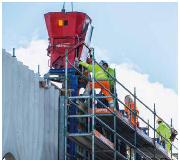
Ein großer Vorteil der NOEplast-Strukturmatrizen ist, dass sie sich bis zu 100-mal einsetzen lassen. Dies wird auch beim ZSC-Lions-Projekt genutzt.
