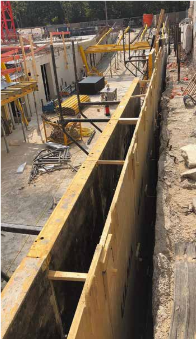
Herrscht zwischen dem Verbau und der Außenkante der Wand Platzmangel, dann empfiehlt sich der Einsatz einer Stahlblechsonderschalung als Vorstellschalung.
