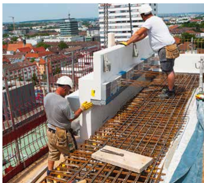
Vor Ort wurden die querliegenden Gesimse mit dem eingebauten Schöck Isokorb über die Pilaster gelegt und durch eine Deckentisch-Sonderkonstruktion provisorisch abgestützt.
