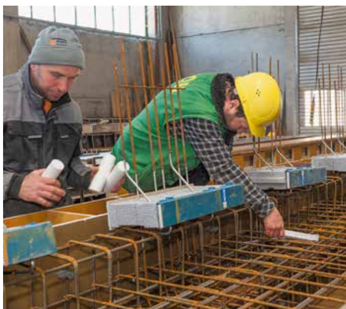
Vor dem Betoniervorgang wurde das Element Schöck Isokorb auf die Länge von 500 mm halbiert und jeweils mit 500 mm Abstand eingebaut. Bilder: Schöck
