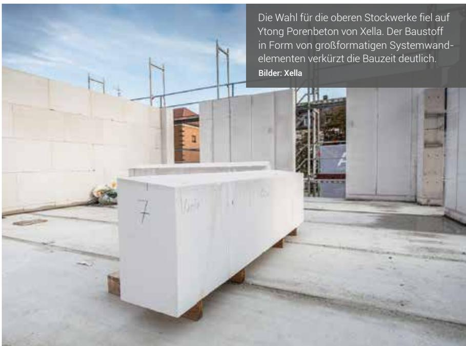
Die Wahl für die oberen Stockwerke fiel auf Ytong Porenbeton von Xella. Der Baustoff in Form von großformatigen Systemwandelementen verkürzt die Bauzeit deutlich.
