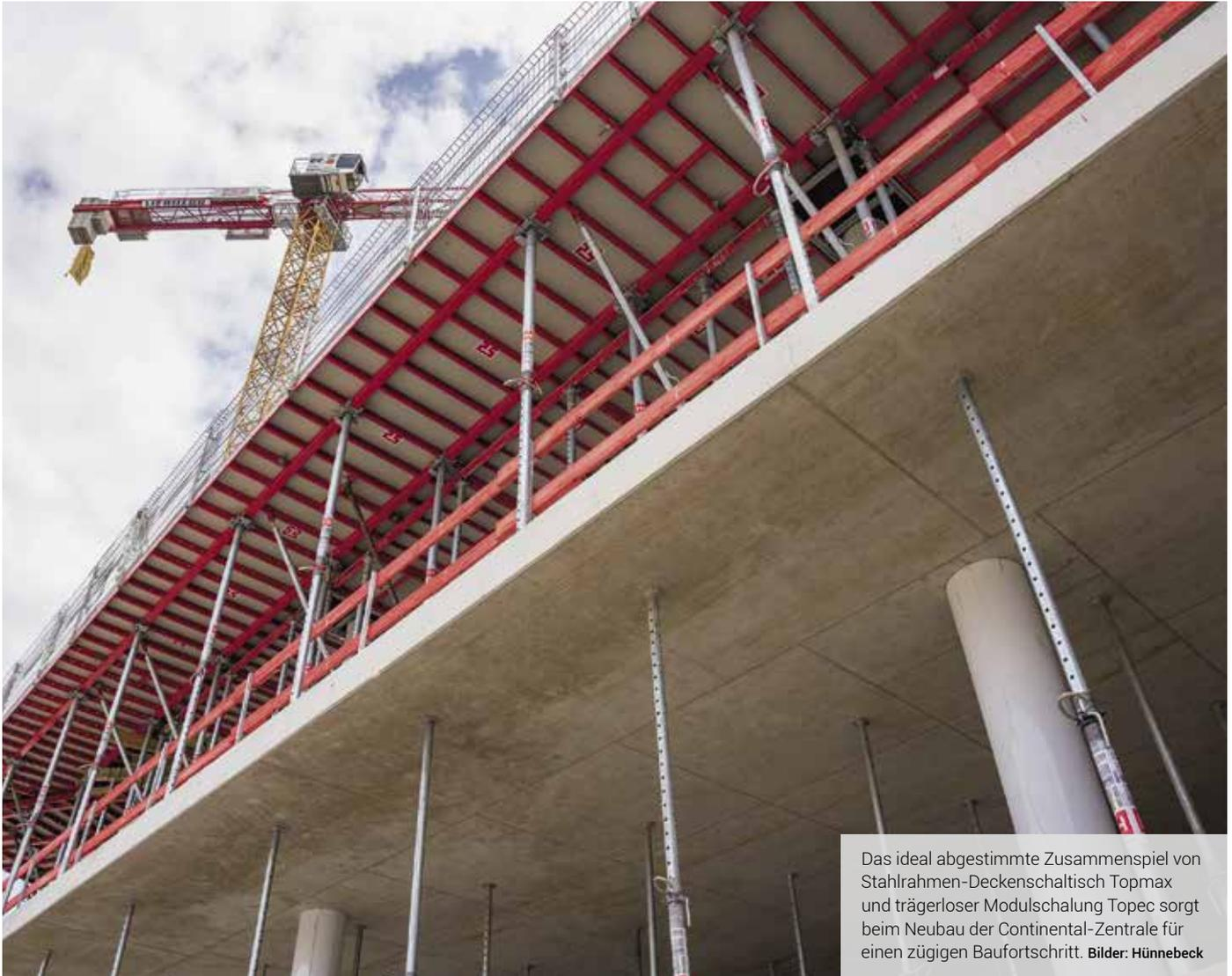
Das ideal abgestimmte Zusammenspiel von Stahlrahmen-Deckenschaltisch Topmax und trägerloser Modulschalung Topec sorgt beim Neubau der Continental-Zentrale für einen zügigen Baufortschritt. **Bilder: Hünnebeck**
