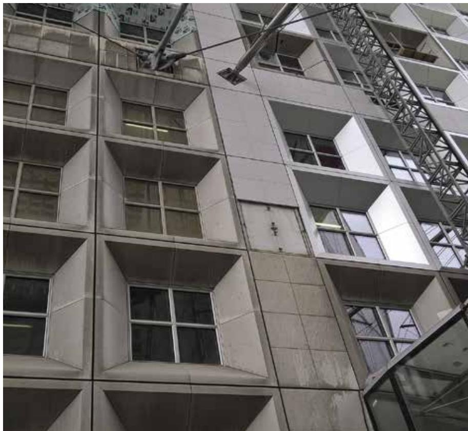
Dank Hinterschnitt weiter sehenswert: An der Fassade der Grande Arche wurden die alten Platten aus Carrara-Marmor (links im Bild) gegen neue Granitplatten (rechts im Bild) ausgetauscht, die Zykon-Plattenanker FZP-II von Fischer befestigen.
