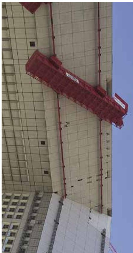
Mobile Zugangsplattformen ermöglichten sichere und produktive Austauscharbeiten an der Tesserakt-Fassade. **Bilder: Fischer**
