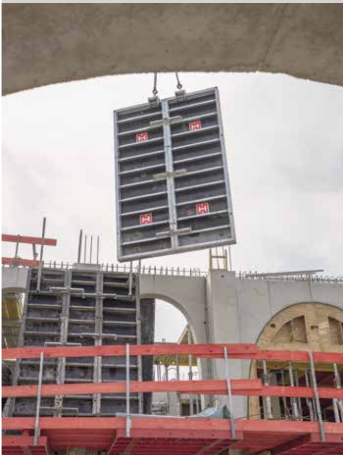
Auf der Baustelle waren rund 1.400 m 2 der Manto Großrahmenschalung im Einsatz. Bilder: Hünnebeck
