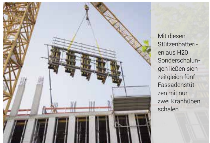
Auf der Baustelle waren rund 1.400 m 2 der Manto Großrahmenschalung im Einsatz. Bilder: Hünnebeck
