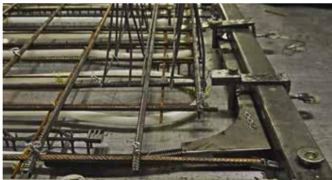
Schaltisch mit eingelegten Rohrschlangen. Insgesamt lieferte Abi-Beton 2.830 m<sup>2</sup> Wandelemente.
