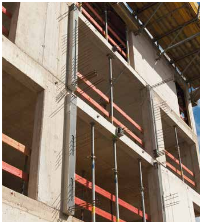
Die seitlichen Wände wurden für die statische Befestigung der Frames genutzt und mit dem Isokorb WXT angeschlossen. Bilder: Schöck
