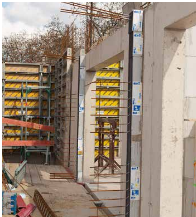
Die Befestigung der Betonrahmen konnte problemlos mit Hilfe des Schöck Isokorb Typ WXT realisiert werden.
