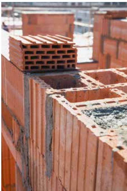
Schallschutz im Detail: Hier durchstößt eine Trennwand die Längswand und reduziert so die flankierende Schallübertragung deutlich.
