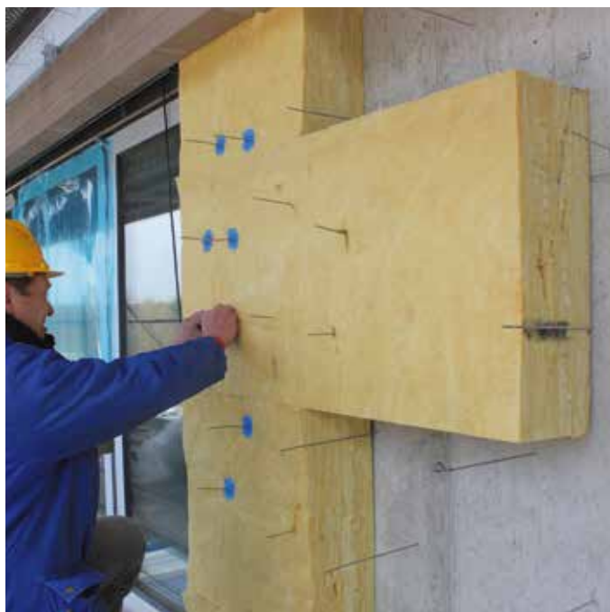
Mit ihrer niedrigen Wärmeleitfähigkeit eignet sich URSA GEO ideal für eine energieeffiziente Gebäudehülle. Bilder: Ursa
