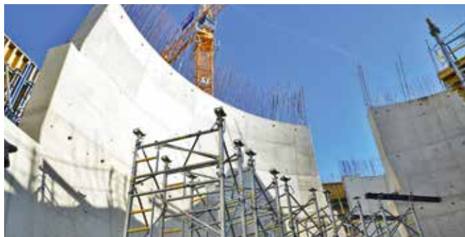
Die Herausforderungen an die Schalung für die geneigten und gleichzeitig gekrümmten Wände sind groß.
