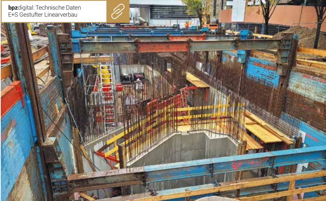
Für die Sicherung der knapp 9 m tiefen, 10 m breiten und annähernd 30 m langen Baugrube des Verteilerbauwerks mit Wärmeübergabestation kam der E+S Linearverbau zum Einsatz.
