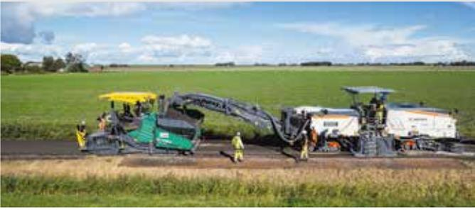
Der SUPER 2100-5i kann mit einem zusätzlichen Aufsatzbehälter bis zu 20 t Mischgut aufnehmen und bis zu 1.100 t pro Stunde einbauen.
