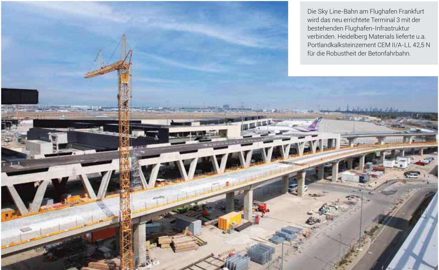
Die Sky Line-Bahn am Flughafen Frankfurt wird das neu errichtete Terminal 3 mit der bestehenden Flughafen-Infrastruktur verbinden. Heidelberg Materials lieferte u.a. Portlandkalksteinzement CEM II/A-LL 42,5 N für die Robustheit der Betonfahrbahn.
