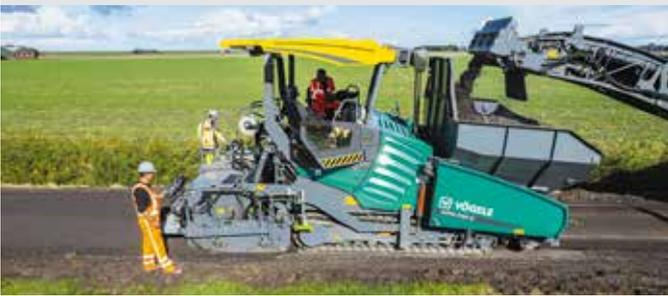
Schaumbitumen mittels integrierter Vario-Einsprühleiste – im Mischraum zu homogenem BSM auf. Danach übergab der W 240 CRI das Material an den nachfolgenden Vögele Fertiger, der die 15 cm starke Tragschicht mit einer Geschwindigkeit von rund 4 m pro Minute einbaute. Nach Abschluss der Recyclingarbeiten versiegelte der SUPER 2100-5i die Tragschicht mit einer 4 cm dicken Asphalt-Deckschicht.
