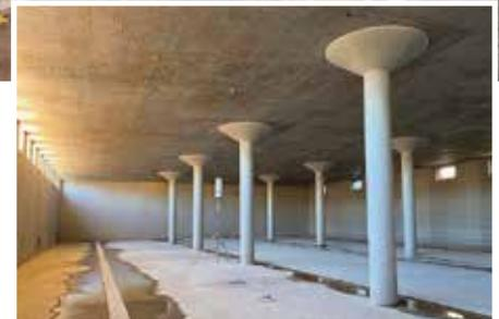
Bodenplatte und Decken wurden in Ortbetonbauweise erstellt, die Wände bestehen aus Halbfertigteilen.
