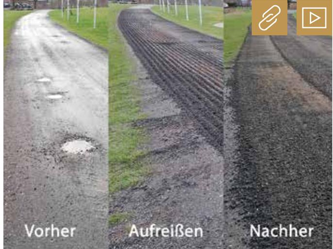
Mit dem Planierhobel lassen sich mit wenig Aufwand innerhalb kurzer Zeit entweder neue Flächen schaffen oder bereits vorhandene Wege oder Plätze wieder Instand setzen.
