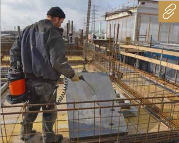
Die neuen Trennmittlemulsionen Ortolan Bio 800 und 880 überzeugen durch eine gute Trennwirkung und ermöglichen hochwertige Betonoberflächen und Sichtbetone.
