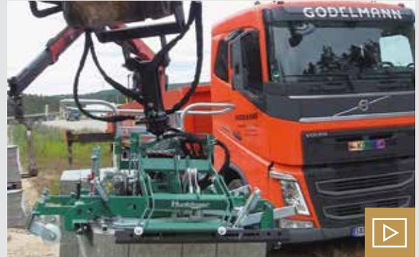
Innovative Pflasterzange von Hunklinger sorgt für fachgerechte und effiziente Verlegung. Bild: Hunklinger
